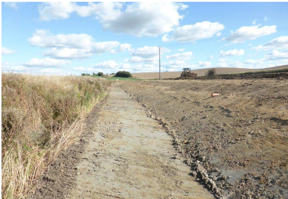
Figur 3-18 visar tvåstegsdike 3 direkt efter anläggning Foto: Johnny Carlsson
