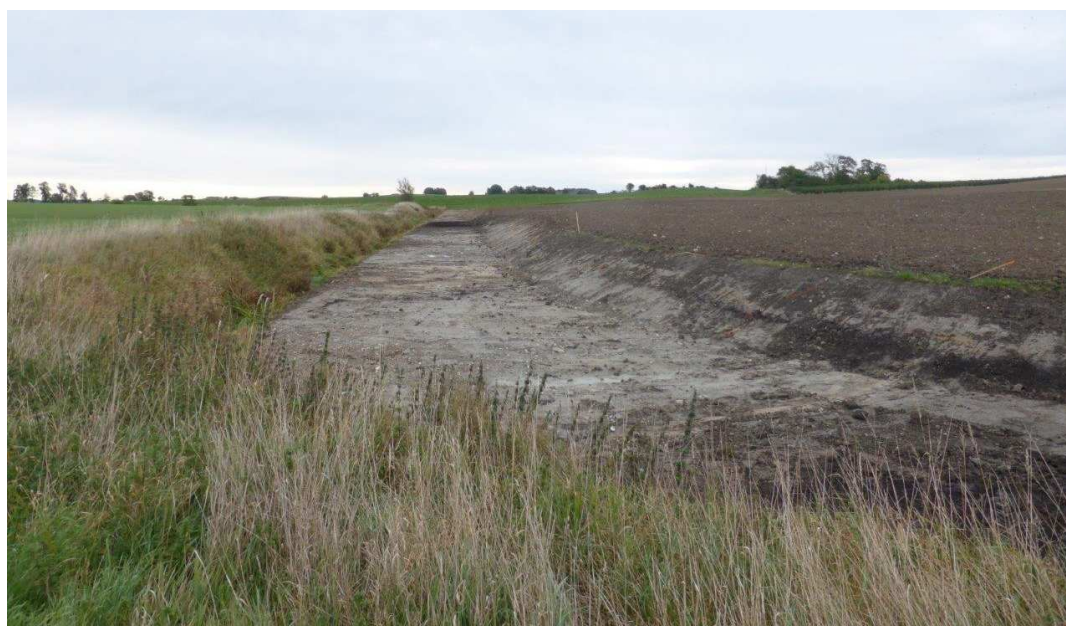
Figur 3-5 visar tvåstegsdike 1 direkt efter anläggning 2013. Foto: Johnny Carlsson
