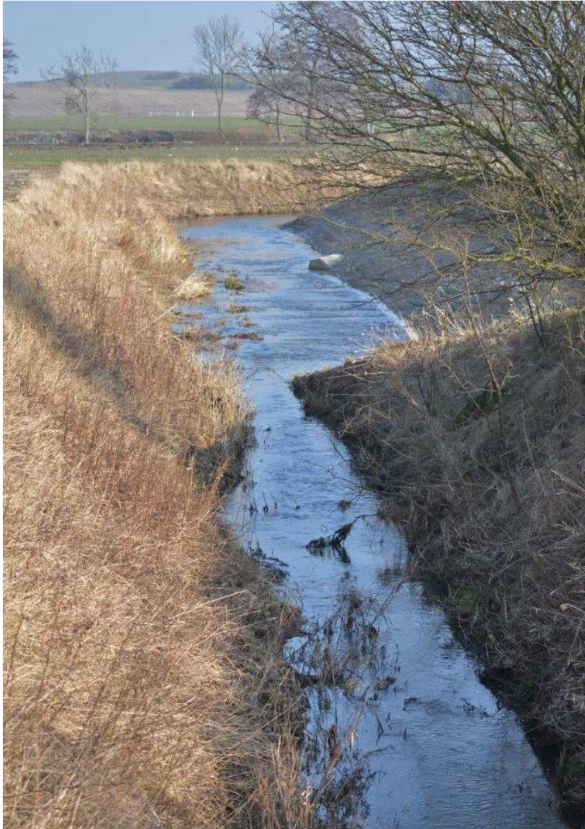
Figur 3-11 visar början på tvåstegsdiket med flödesterrass på en sida. Foto: Bengt Gunnarsson
