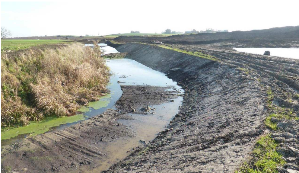
Figur 3-15 visar anläggning av tvåstegsdike och våtmark 2013 Foto: Johnny Carlsson
