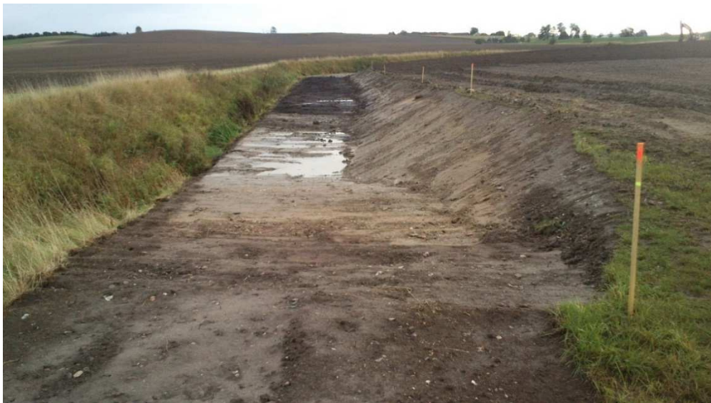
Figur 3-7 visar tvåstegsdike med ramp ner till flödesterrassen. Foto: Henrik Kivivuori
