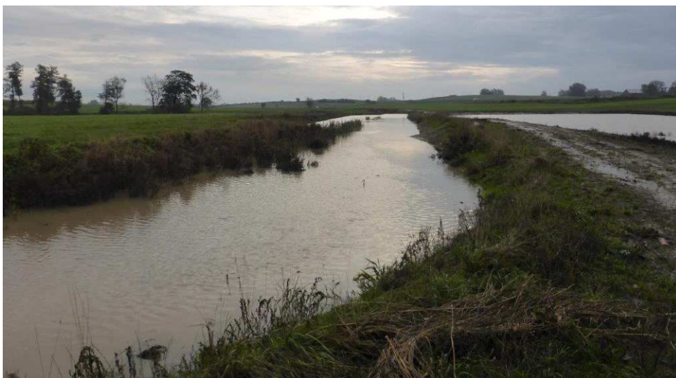
Figur 3-16 visar tvåstegsdike vid en högflödessituation ca ett år efter anläggning Foto: Johnny Carlsson
