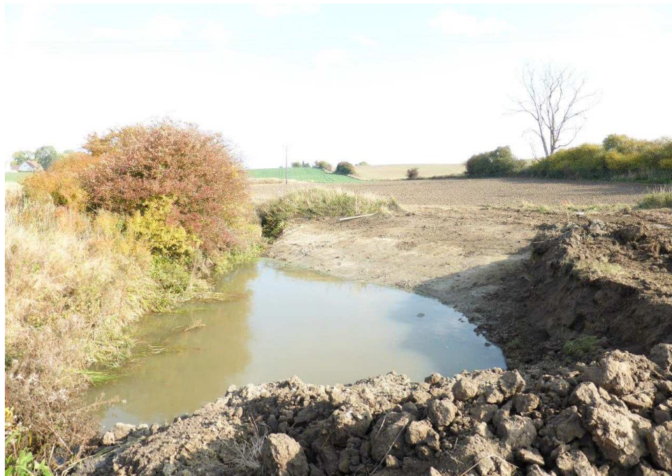
Figur 5-1 visar slamfälla 1 under pågående anläggning Foto: Johnny Carlsson
