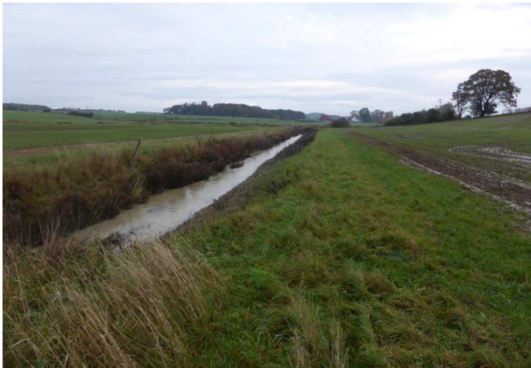
Figur 4-2 visar kantavplanad dikessträcka på Stora Markie (ena sidan av diket) Foto: Johnny Carlsson
