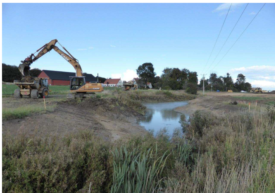
Figur 5-2 visar slamfälla 2 under pågående anläggning Foto: Johnny Carlsson
